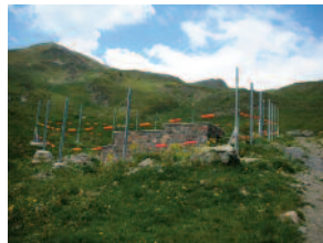
2 captacions sobre el dipòsit de Gasopas
