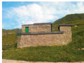
Dipòsit de Gasopas
