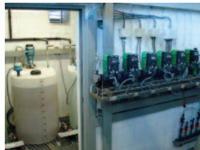
Sala de reactius i bombes dosificadores
