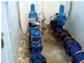
Línies d'entrada a la ETAP provinents de les captacions de la Molina-Montuèll i de Feritxet respectivament
