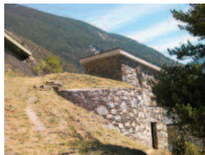
Dipòsit de Vila
